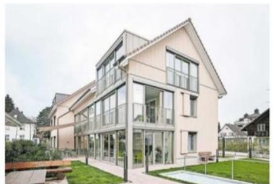
2022 wurde dieser dreigeschossige Neubau erstellt.
